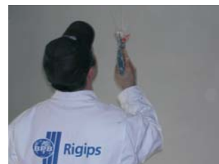
Naprskavanje disperzije vrši se precizno i ravnomerno, bez rastura.
