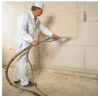
Suv praškast materijal u mašini meša se sa vodom i preko creva nabacuje na zidove i plafone
