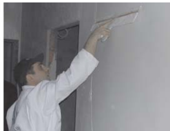
Gletovanje zidova širokom gletericom (leptirom) do perfektne glatkoće.
