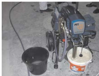
Postavljanje kante sa pastoznom glet masom ispod usisnika Graco Mark V mašine.
