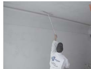
Gletovanje plafona bez skele i merdevina pomoću teleskop gleterice (leptira).
