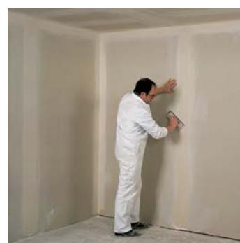
6) Kad lepak očvrsne, vrši se ispunjavanje, bandažiranje i gletovanje spojeva ploča.
