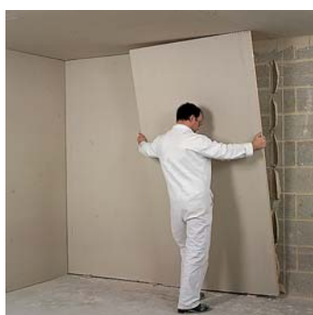
4) Rigitherm ploče sa izolacijom, spratne su visine i lepe se na zid.
