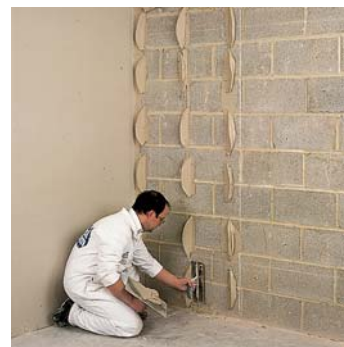
3) Lepak za ploče nanosi se u tri vertikale, kao i uz pod i uz plafon.
