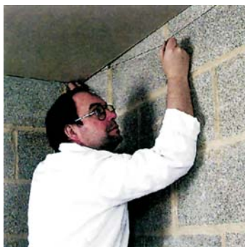
1) Obeležavanje se vrši prema dimenzijama ploča, na podu i plafonu.
