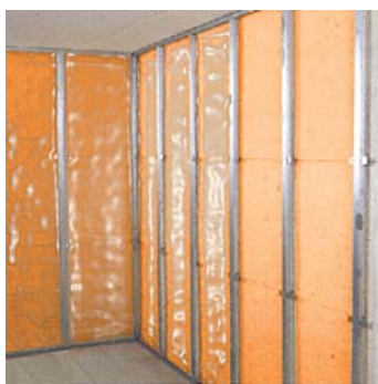
5) Šupljine se ispunjavaju Isover mineralnom vunom, koja je kaširana parnom branom.
