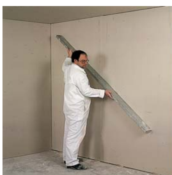
5) Poravnavanje ploča vrši se dugačkom ravnjačom u svim pravcima.
