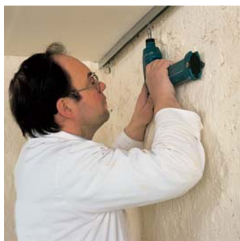
1) Rigistil U-profilu 20/20/30 montiraju se na pod i plafon.
