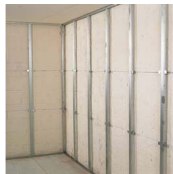
3) Nakon montaže Rigistil potkonstrukcije sprovede se instalacije.
