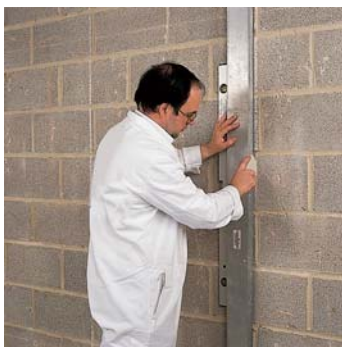
2) Obeležavanje na zidu se vrši na svakih 1,2 m, koliko iznosi širina ploča.
