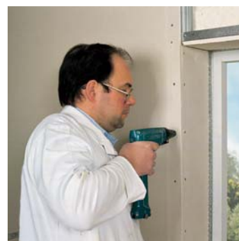
6) Rigips ploče se montiraju pomoću električnog uvrtača, a zatim se gletuju spojevi.
